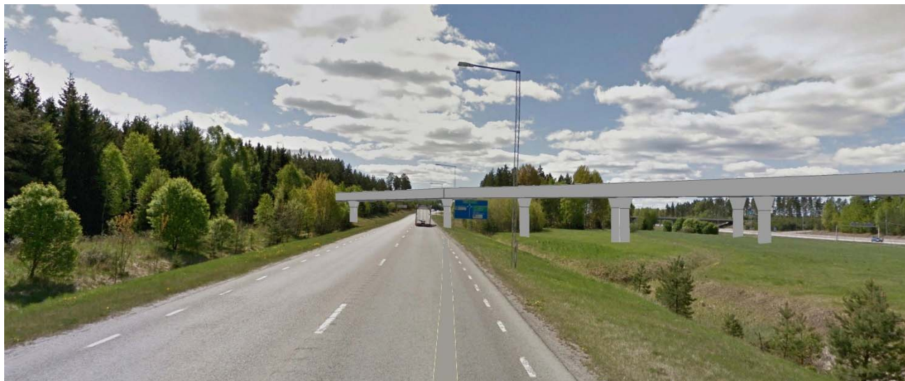
Figur 8 Bro över väg 273
